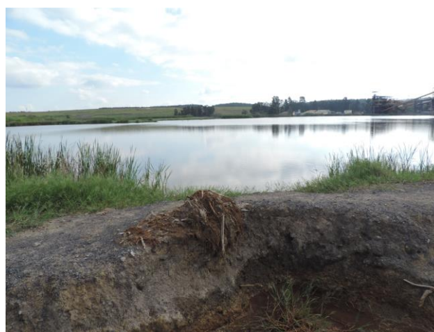
Figura 16. Talude da vala erodido, mostrando a vazão de efluente bruto que circula no local.
