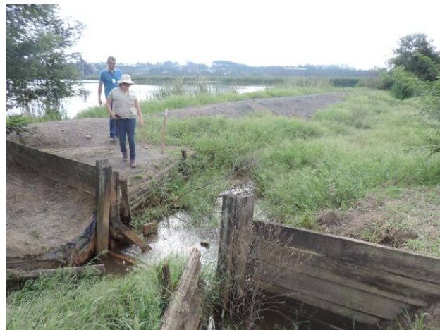
Figura 14. Detalhe do vertedouro de madeira, quebrado.
